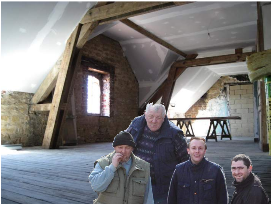
Le grenier de la maison de la Renaissance est à présent isolé. Les plafonds ont été refaits et les fenêtres de toit remplacées.
