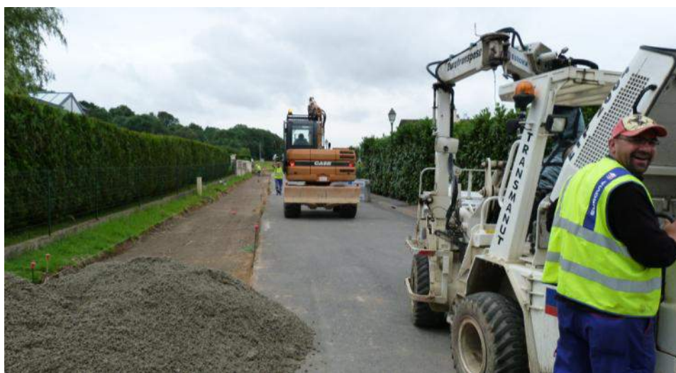
La création de ce parking complète le programme présenté en 2008 en matière de voirie.
