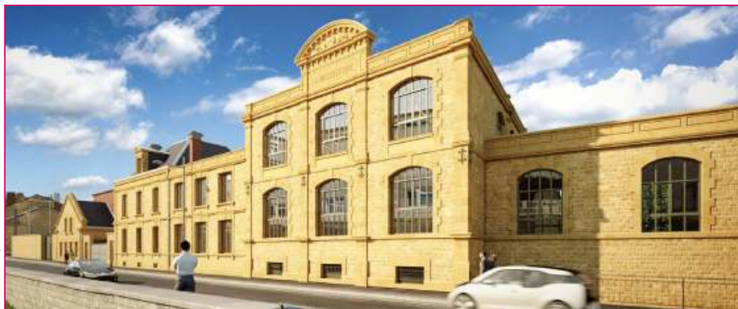
Située au cœur de Mézières, la friche de la Macérienne est vouée à terme à accueillir le siège d'Ardenne Métropole
