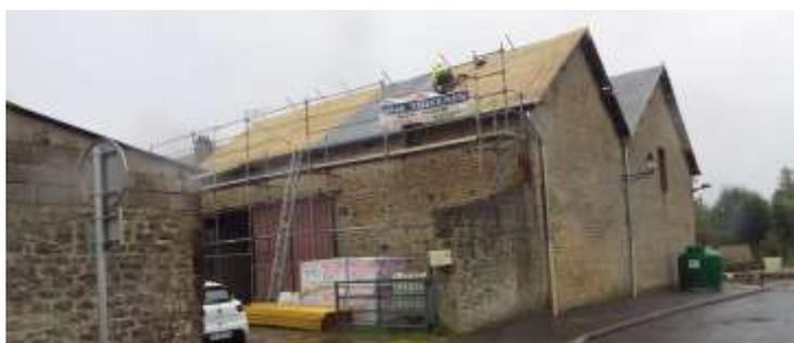
L'eau et le vent menaçaient sérieusement l'édifice à la charpente partiellement dégradée et la couverture tuiles et ardoises percée en de multiples endroits.
