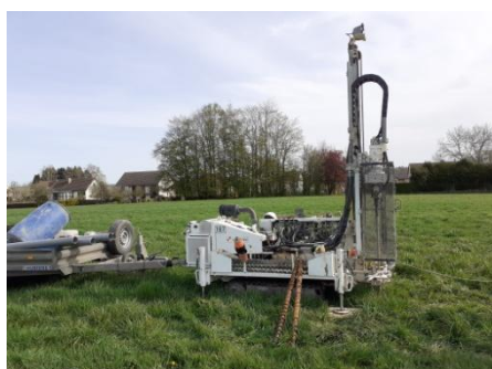
Figure 3 : Sondage géotechnique en amont de Frenois
