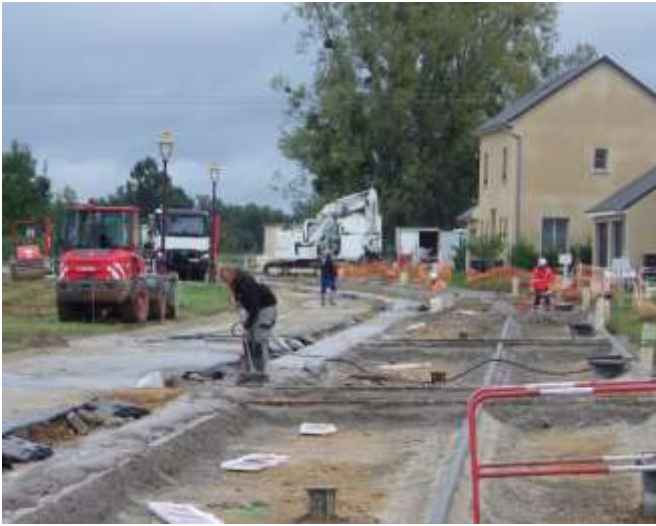
Pendant les six semaines de travaux
